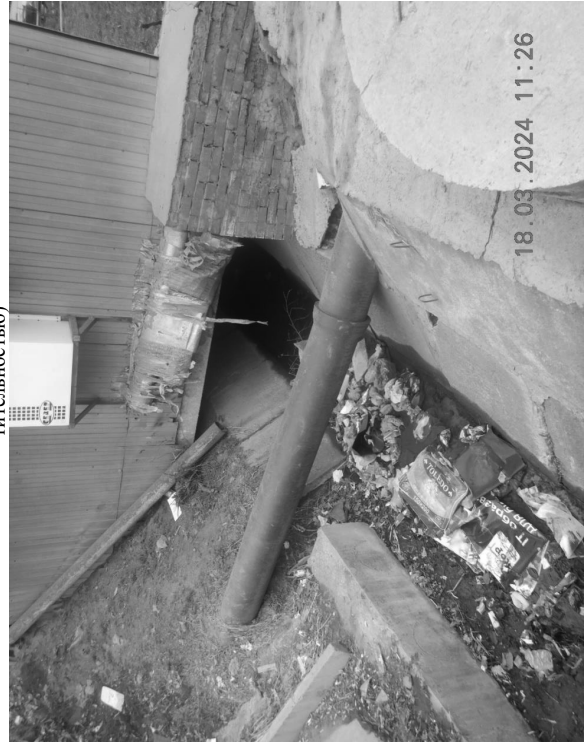
Рисунок 17 – улица Огородная, 66/3 (замусоренный лоток)
