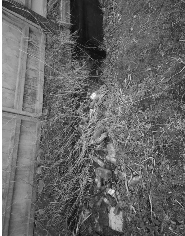
Рисунок 19 – улица Куйбышева, 169 (замусоренный лоток)
