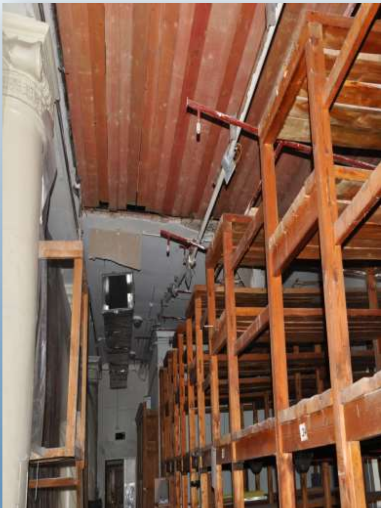
Архивохранилище ГАРО во время ремонта
